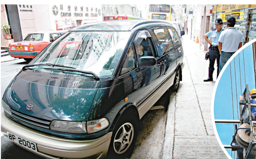
▲遭玻璃碎片擊碎天窗的七人車 ▲爆裂的玻璃幕牆面積約五呎乘三呎
