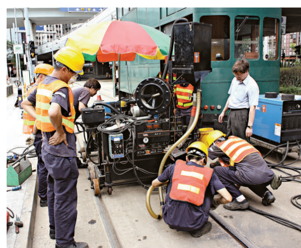
▲電車公司購入新設備，令修復路軌的時間可大幅縮短
