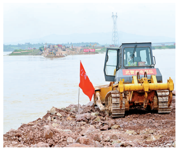
▲二十六日，武警水電部隊在撫州唱凱堤上游決口處施工 新華社
