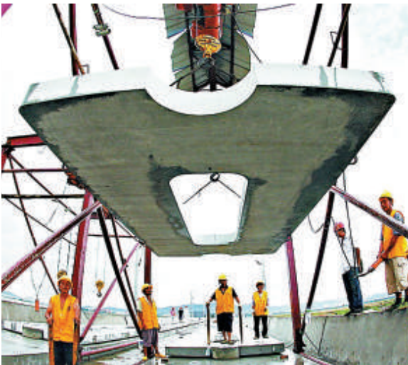
▲廣珠城軌今年8月底之前將完成全線鋪軌，圖為軌道板鋪設現場 方俊明攝
