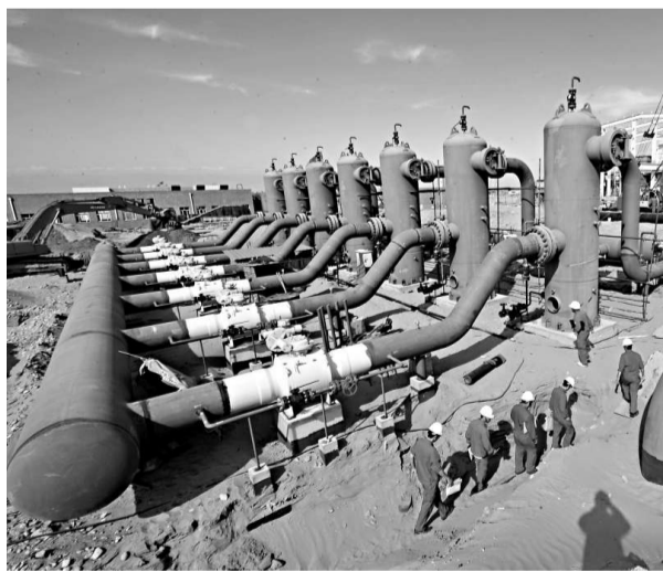
▲西氣東輸二線工程是中國第一條引進境外天然氣的大型管道工程，首站位於新疆霍爾果斯。新華社
