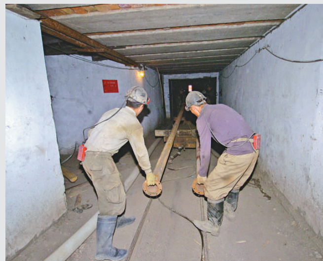
▲二十日，在金塔煤礦透水事故現場，救援人員正在架設排水管道。新華社
