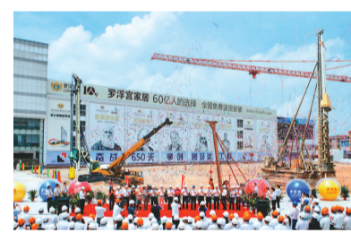
羅浮宮國際家居總部大廈破土動工
