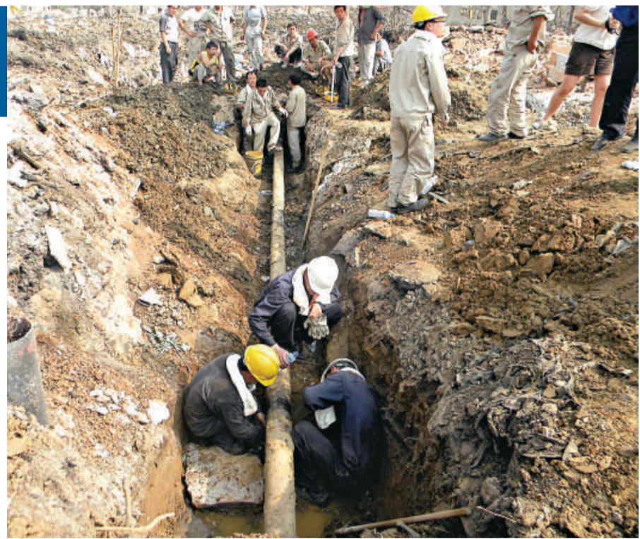
▲南京加緊修復因丙烯洩露引發爆炸的管道
