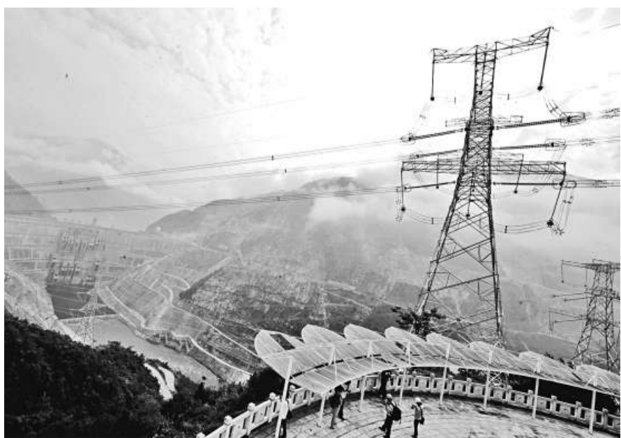
▲雲南小灣水電站4號機組25日投產發電 新華社
