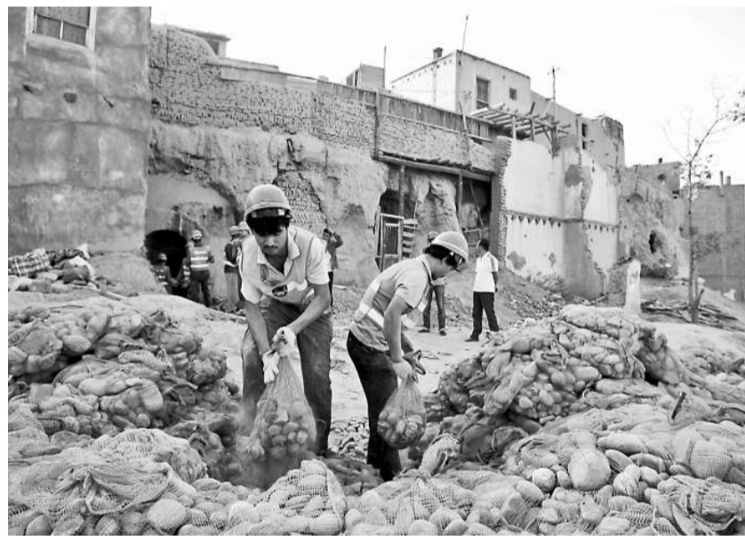
8月29日，已有2000多年歷史的新疆喀什高台民居，工作人員正將石塊運進其下部的空洞，進行加固修繕工程。
