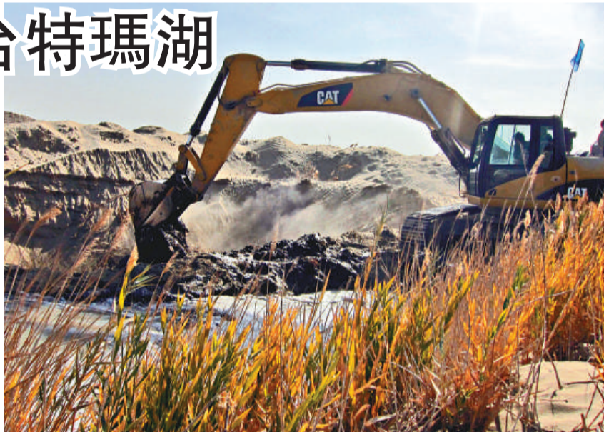
▲塔河第11次生態輸水成功到達尾閘，圖為塔里木河的下游清淤河道。新華社
