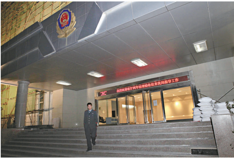
►原鄭州市公安局經濟技術開發區分局辦公大樓正在進行外部裝修。楊家軍攝
