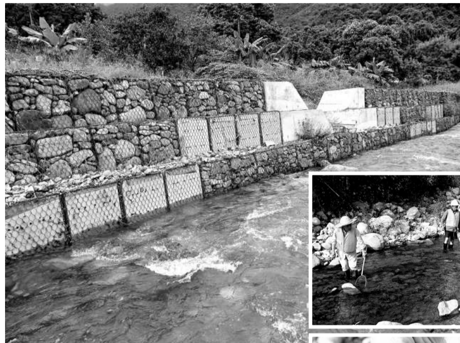
工程人員在河道旁設置石籠，增加防洪能力 渠務署提供
