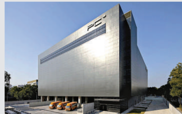
▲大埔工業村嘉里物流產品組裝及整合中心（PC3）大樓
