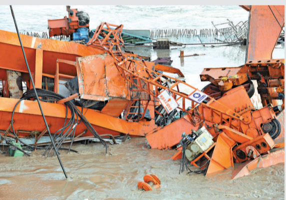
▲嘉紹跨江大橋斷塌事故現場 新華社
