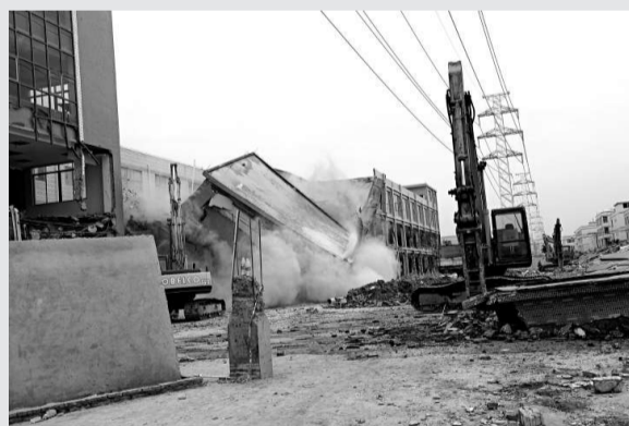
▲廣州市依法拆除違法現場 呂劍攝
