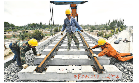
▶ 經過兩年建設，新疆喀什至和田鐵路鋪軌已過半 新華社
