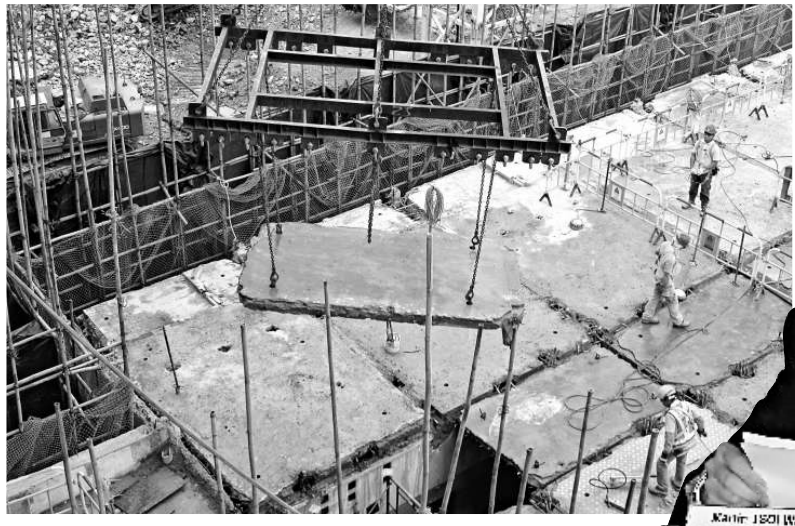
▲▼牛下其中五幢樓宇以預製件建築而成，在拆除時需要整塊石屎移走
