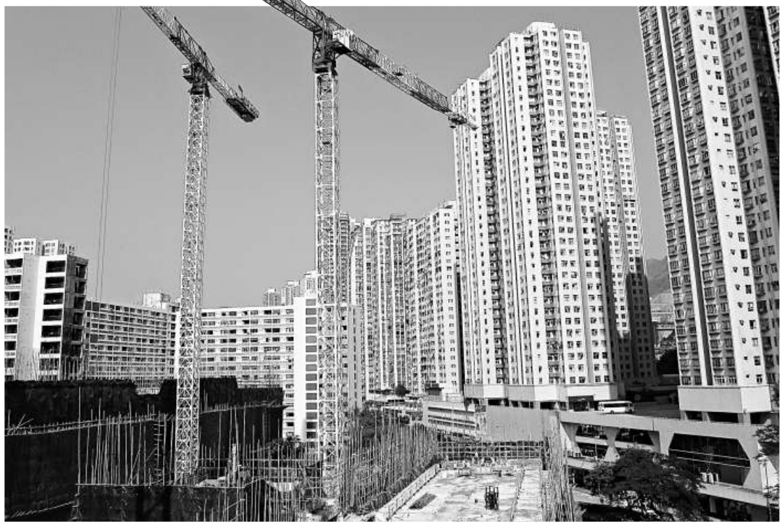
▲▼牛下其中五幢樓宇以預製件建築而成，在拆除時需要整塊石屎移走
