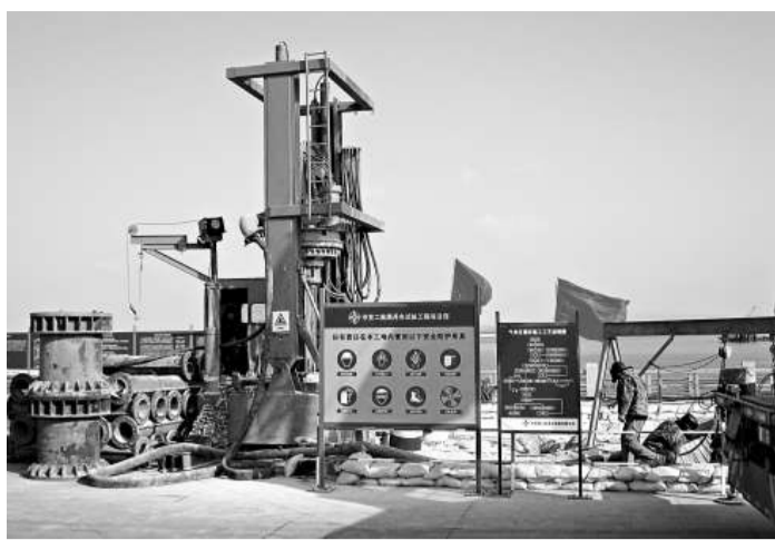
▲新鴨綠江大橋試樁現場
