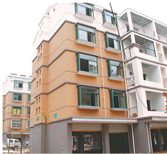
鳳台縣願橋煤礦首採區沉陷村莊搬遷安置點
