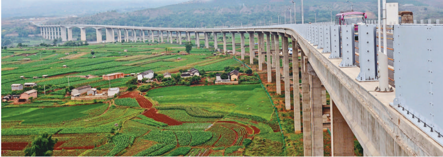
▼位於中緬邊境、雲南保龍高速公路上的怒江特大公路橋
