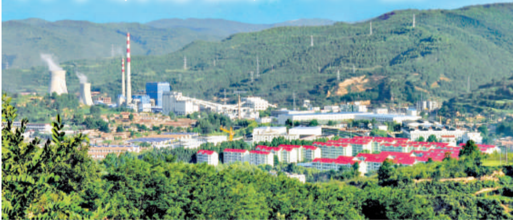
陝西煤業化工集團建設的資源節約型、友好型礦區
