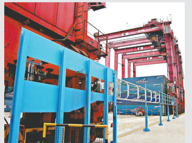
▲現代貨箱碼頭把94台膠輪式龍門起重機改裝為以電力驅動
