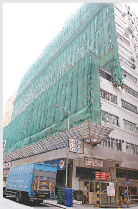
◀警方懷疑賊人見大廈外牆架起棚架趁機犯案 本報攝
