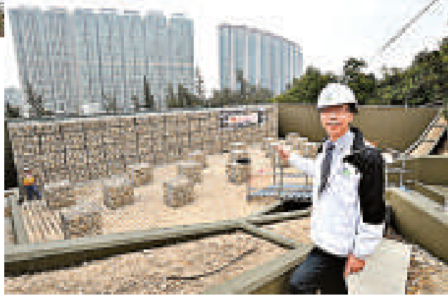
▲東涌裕東路的天然山坡以混凝土泥石壩及柔性防護網加固
