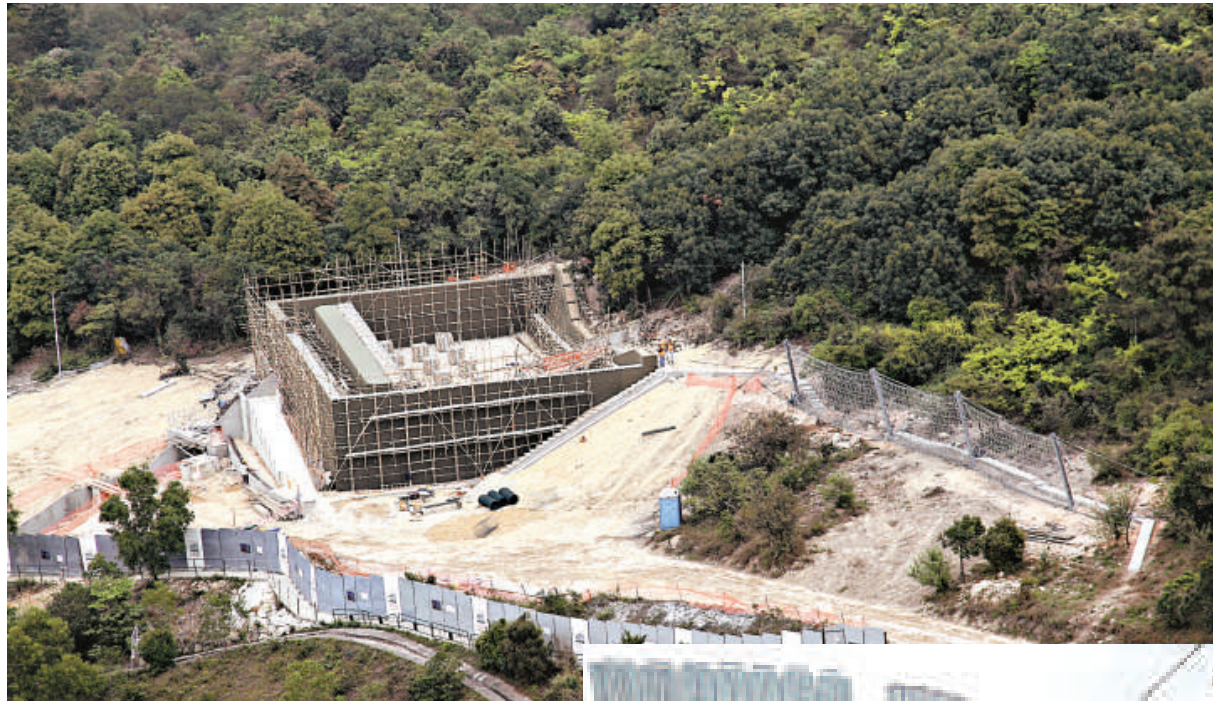
▲東涌裕東路的天然山坡以混凝土泥石壩及柔性防護網加固
