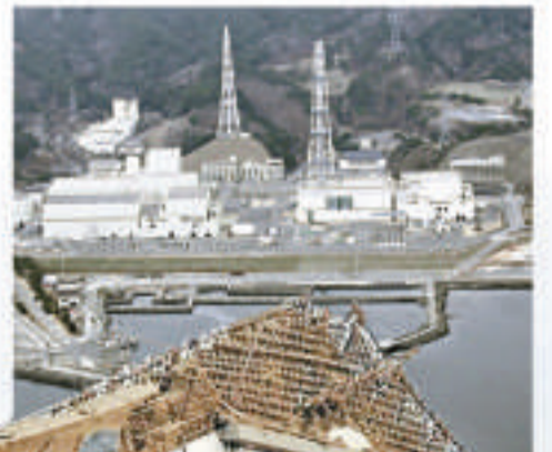
▲ 宮城縣的女川核電站在地震中漏出了輻射水 路透社
