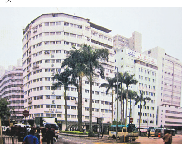
▲柴灣利眾街蜆殼工業大廈鄰近港鐵站
