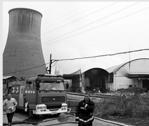
▲14日19時至15日10時許，位於湖南省株洲市境內的一個「保險粉」倉庫發生持續火災，連燒最少15小時。目前，消防人員正全力搶險，救援工作正在緊張進行，沒有人員傷亡，地方政府已經密切監測環境和安排周邊市民緊急疏散。
