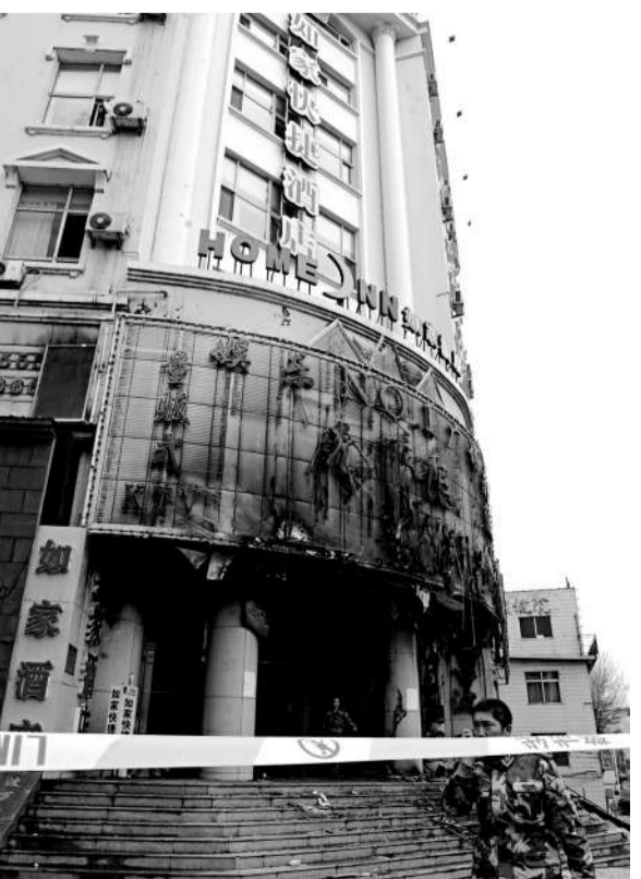
▲圖為火災造成10死35傷的吉林通化市如家快捷酒店。據稱縱火的七名疑犯已全部落網
