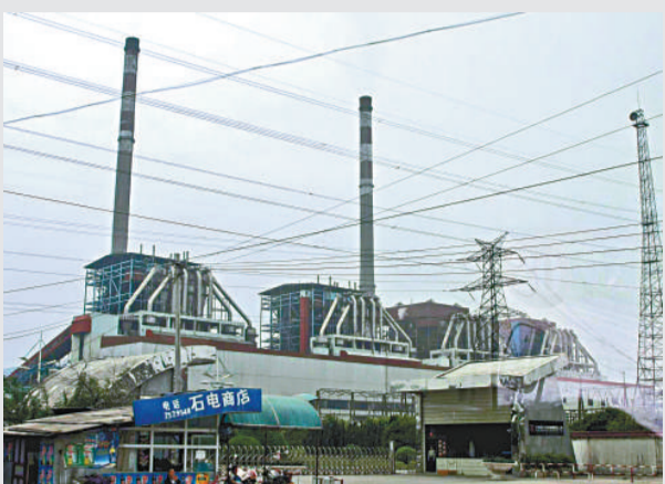
▲湖南石門火電廠機組因缺煤和長時間運行導致故障停機，湘電供應缺口再次增大 楊斌攝
