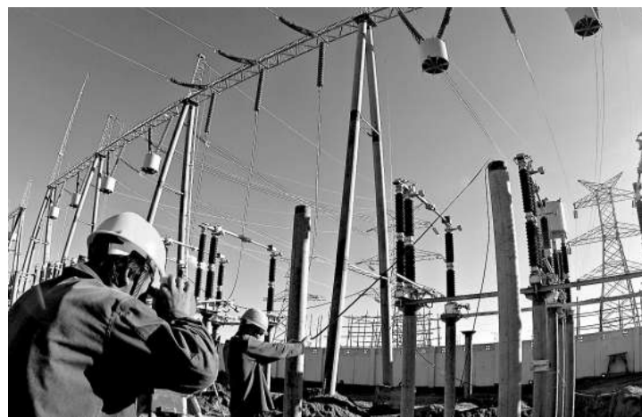
▲施工人員在內蒙古包頭市境內一座變電站建設現場測量
