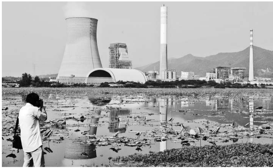
▲近日，由安徽電建二公司承建的安徽首台百萬千瓦超超臨界火電機組建成並投入運行，這也是目前國內單機容量最大的火電機組。圖為二十日，一位記者在拍攝運行中的百萬千瓦超超臨界火電機組
