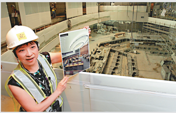
▲新立法會大樓的會議廳正加緊施工 本報攝
