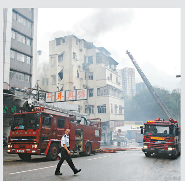
▲紅磡漆咸道北一幢唐樓的天台屋疑因雷劈而起火，冒出大量濃煙
