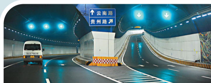
▲膠州灣隧道是中國現今最長的海底隧道
