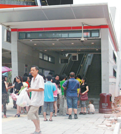
▼ 發生地鐵扶梯「事故」的深圳地鐵4號線清湖站B出口 唐剛強攝
