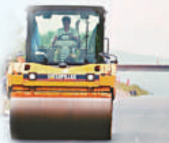
►路面碾壓作業
