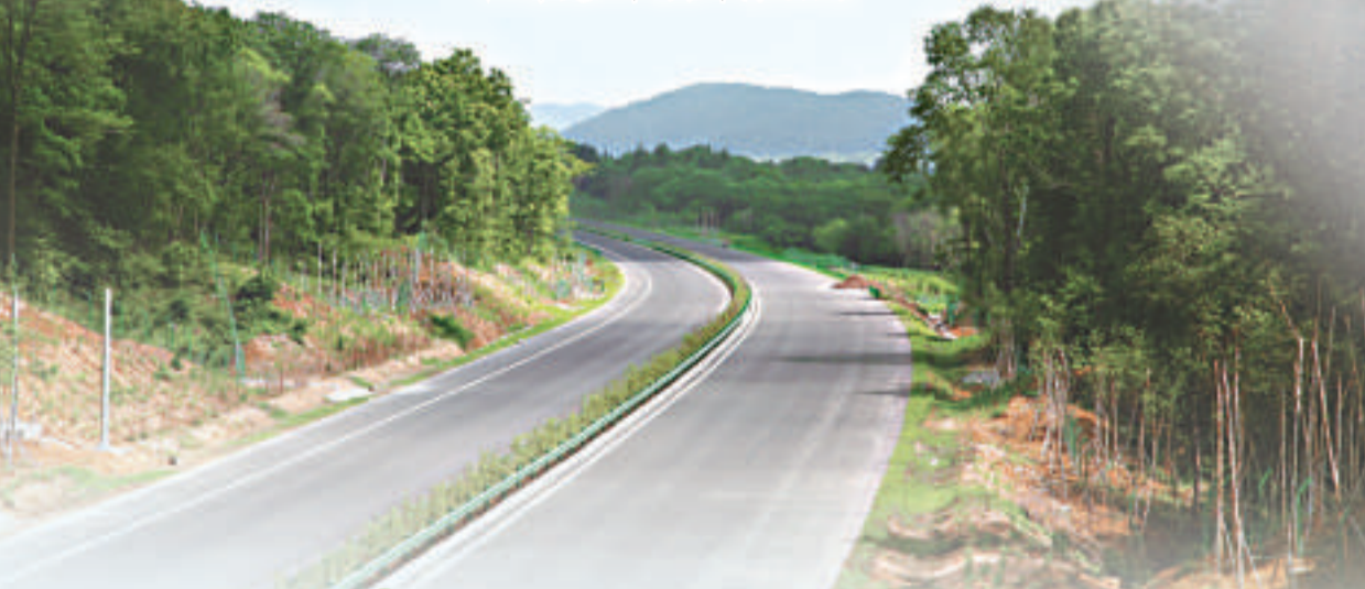
▼正在建設中的吉草高速公路
