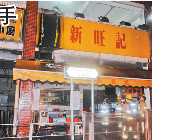
▲失火「打冷」店位於沙田圍路
