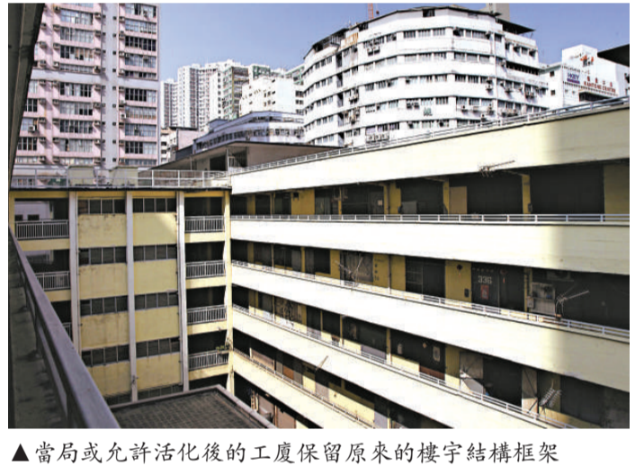
▲當局或允許活化後的工廈保留原來的樓宇結構框架
