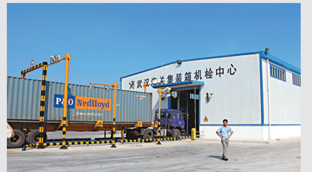
▲ 陽邏港新建集裝箱機檢中心
