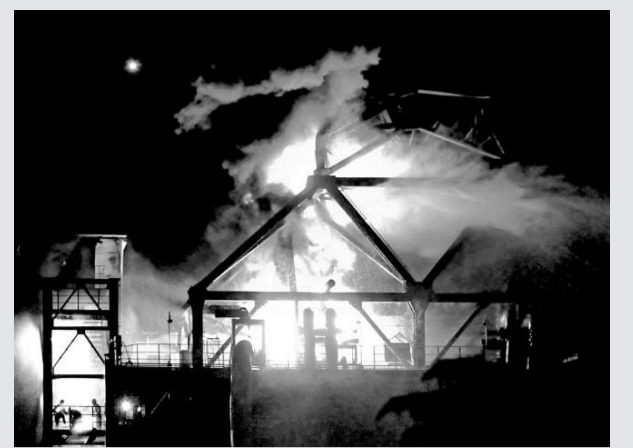
▲高橋煉油廠內的延時焦化裝置火光熊熊 新華社
