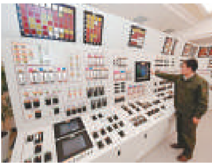
▲「核安全監管技術支持系統——全範圍驗證模擬機」由中廣核集團下屬的中廣核做真技術有限公司負責開發 資料圖片
