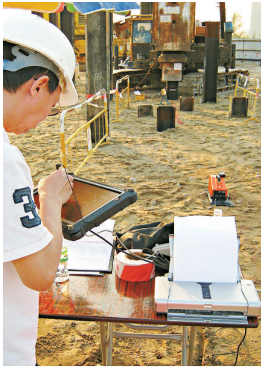
工程人員採用新引入的樁柱貫入度量儀，進行終錘測試。房屋署圖片
