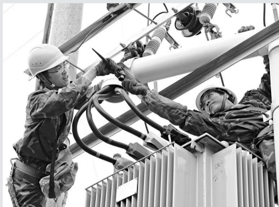
▲廣西今冬明春存在240萬千瓦的電力缺口。圖為供電公司職工在農村電網升級改造工地安裝變壓器 新華社
