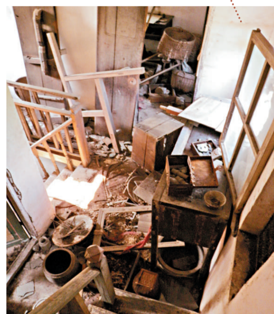
▲荒廢的碉樓成為村民放置雜物的倉庫
