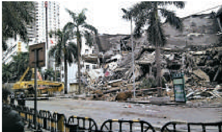
▲(右圖)開發商僱人除夕夜強拆後的現場，部分樓體已經坍塌
