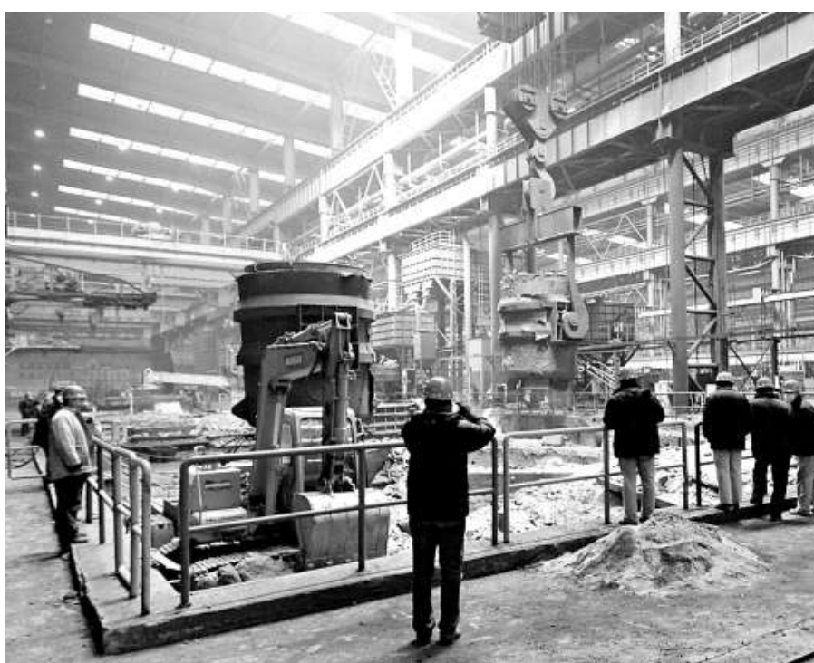
▲鞍鋼鑄鋼廠事故現場
