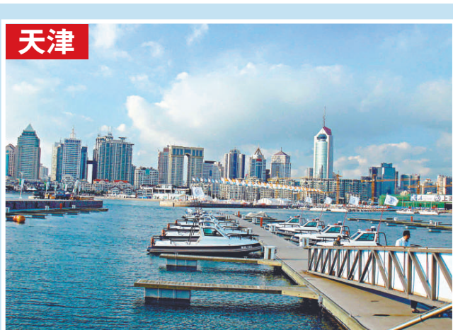
▲正在建設中的天津濱海新區
