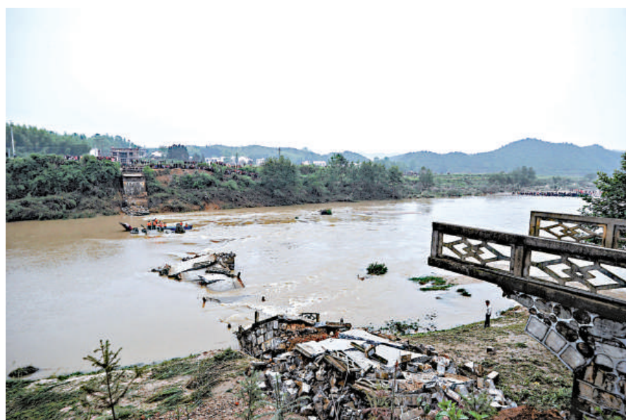
平江山洪沖垮大橋
