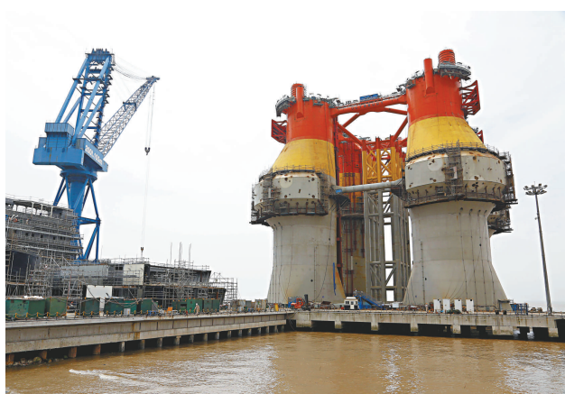
▲中遠海工廠區內，一座具備世界領先水平的「OCTABUOY」八角形半潛式海洋鑽井平台正在建造 鄭雷攝
