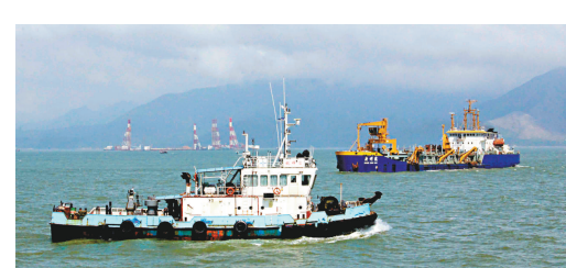
▲測量中的「航鋒8」和施工中的「廣州號」
